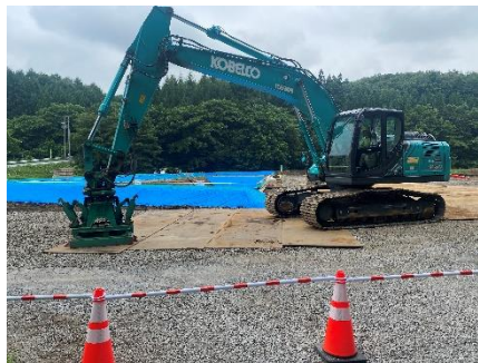
鉄板敷設状況
