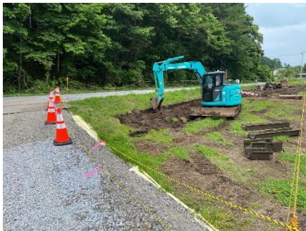
U字側溝撤去状況
