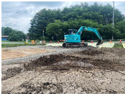
碎石敷均し状況
