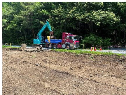
U字側溝撤出状況
